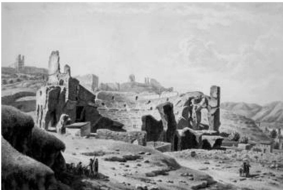
Dibuix de Laborde on podem apreciar el mur que tancava la Jueria pel Teatre Romà.
