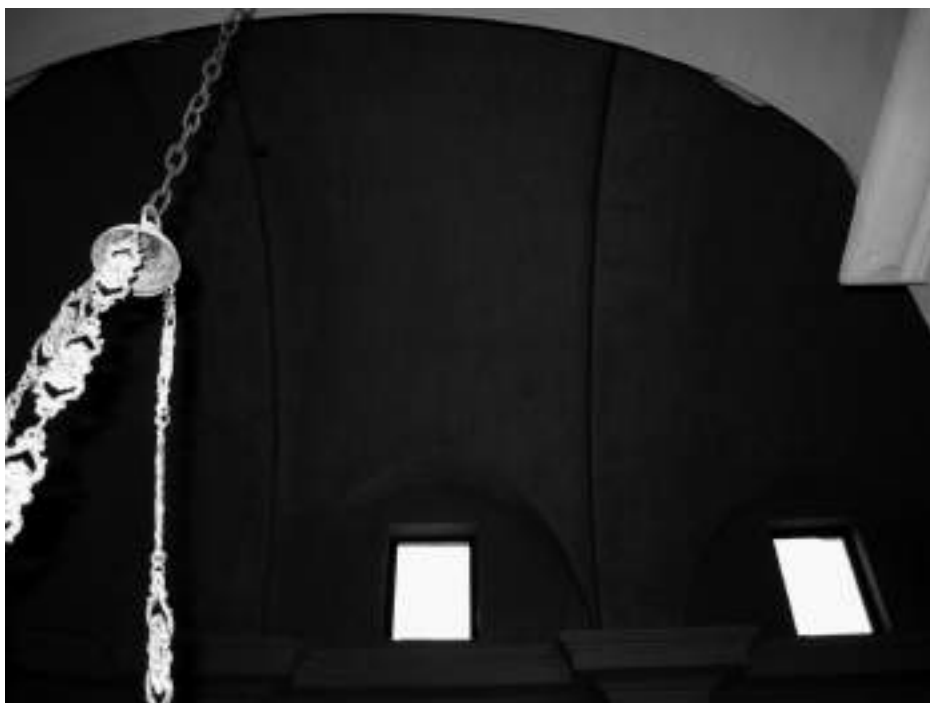
Interior de la Ermita del Calvario de Sagunto. Arcos fajones de la bóveda de cañón principal.
