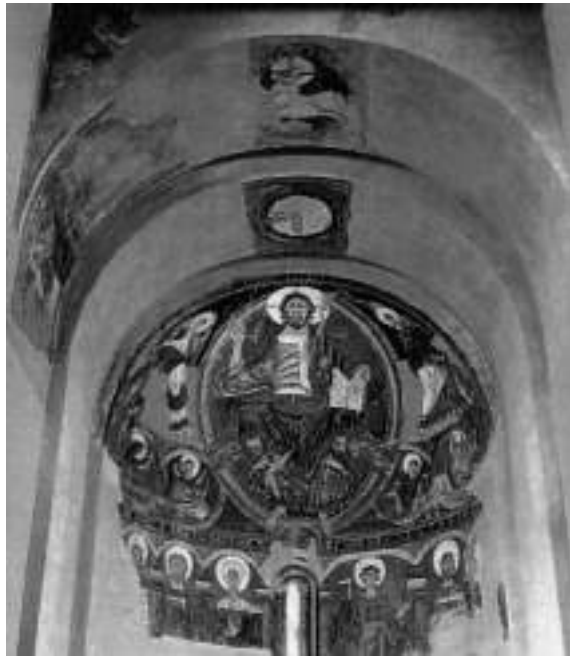
Interior de la Iglesia de San Clemente de Taull. Barruera (Lérida). Entronque de la bóveda de nicho de la cabecera con la bóveda de cañón de la nave.
