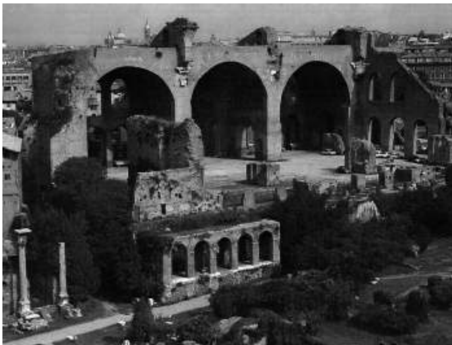
Bóvedas de cañón de la Basílica de Constantino en Roma. Año 308 d.C.
