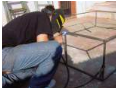
Detalle de la soldadura de la estructura del trono.
