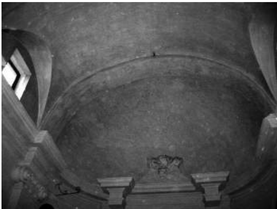
Interior de la Ermita del Calvario de Sagunto. Entronque de la bóveda de nicho de la cabecera con la bóveda de cañón de la nave.
