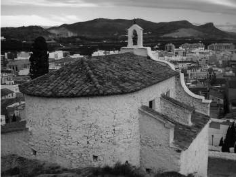
Ermita del Calvario de Sagunto. Vista exterior de los contrafuertes laterales y de la cabecera semicircular.
