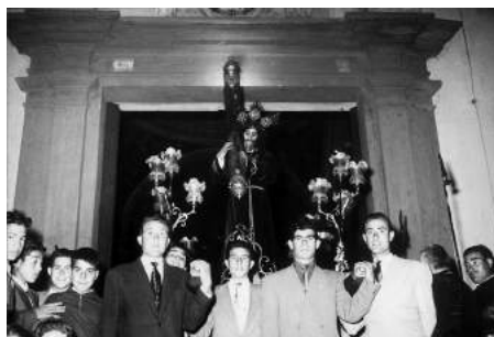
Fotografía propiedad del arreglador Simón Belarte Borguñ. Año 1953. Obsérvese las dobles pilastras, y la cornisa que en sus extremos cambia de plano siguiendo a la pilastra más hundida.
