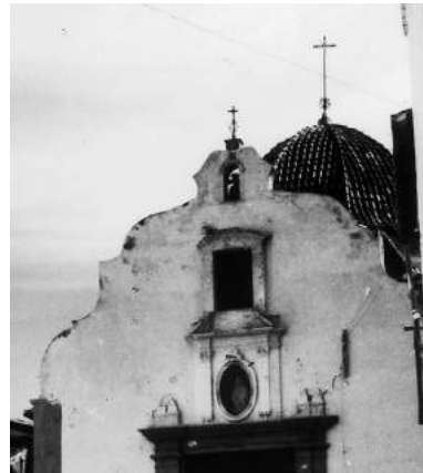
Observar remate de fachada y elementos decorativos sobre la cornisa del portón en nº de dos por lado.
