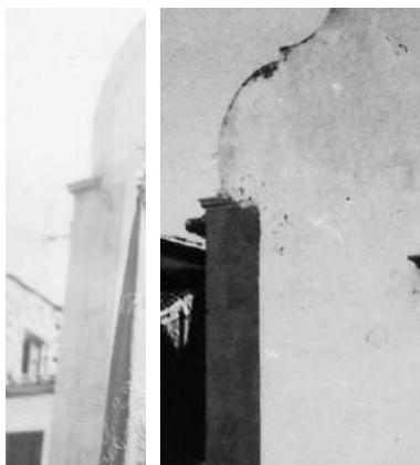
Detalle cornisa de esquina, preludio del movimiento modernista.
