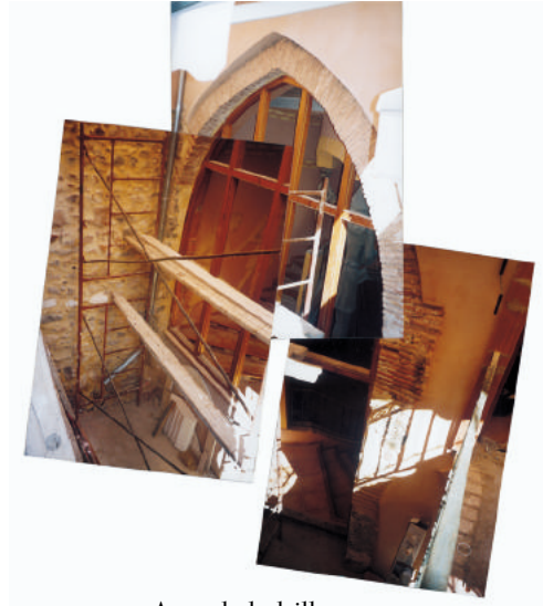
Arco de ladrillo
