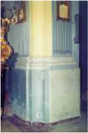
Capas de pintura en distintos colores en el esgrafiado, zócalo.
