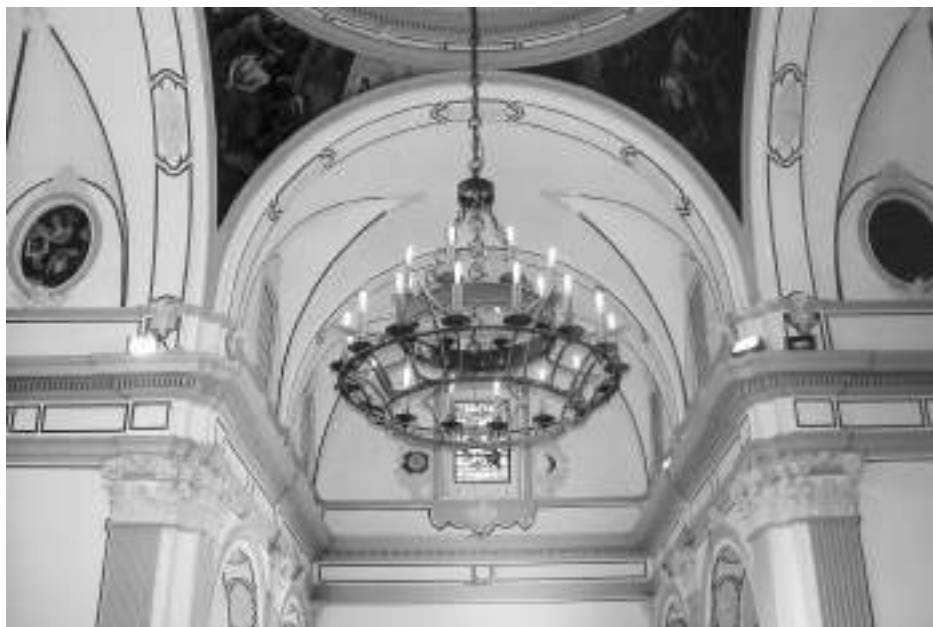
Bóveda de medio cañón con lunetos vista desde el Presbiterio.
