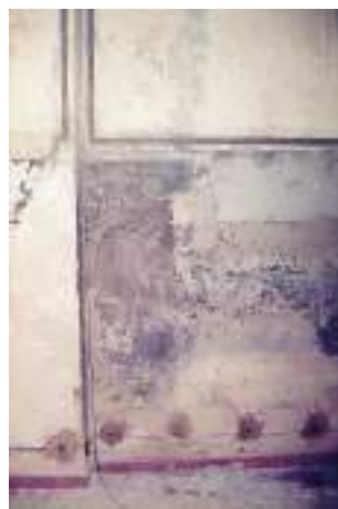
Catas en paredes capilla.
