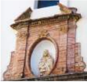
Detalle ornamentación edículo fachada de Ermita de la Sangre.
